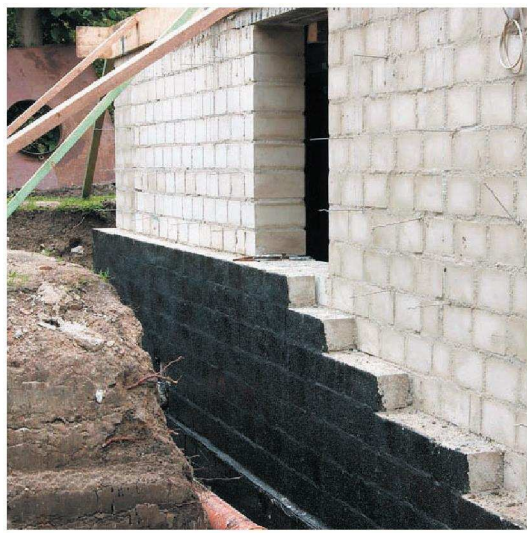
Безшевна и гъвкава изолация на външна стена на мазе със ШВАРЦЕР БЛОКЕР ШУТЦФОЛИЕ.
