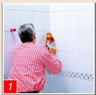
Еластично уплътняване на ъглова фуга със СУПЕР ДИХТ.
