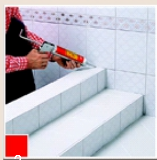
Еластично уплътняване на присъединителна фуга със СУПЕР ДИХТ.
